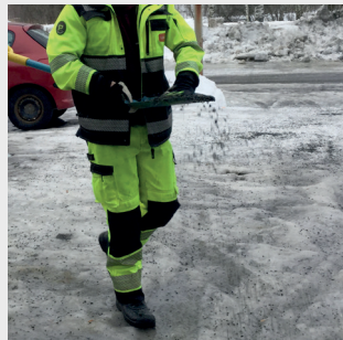
Silta-Kiinteistö: avustavia kiinteistöhuollon töitä, pihatöitä
